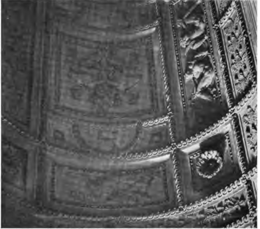
Fig. 159. — Voûte en berceau rampant soutenant les marches de l'escalier du Louvre construit par Pierre Lescot au milieu du xvi e siècle. Division de la voûte en caissons sculptés par arcs doubleaux et nervures transversales.
